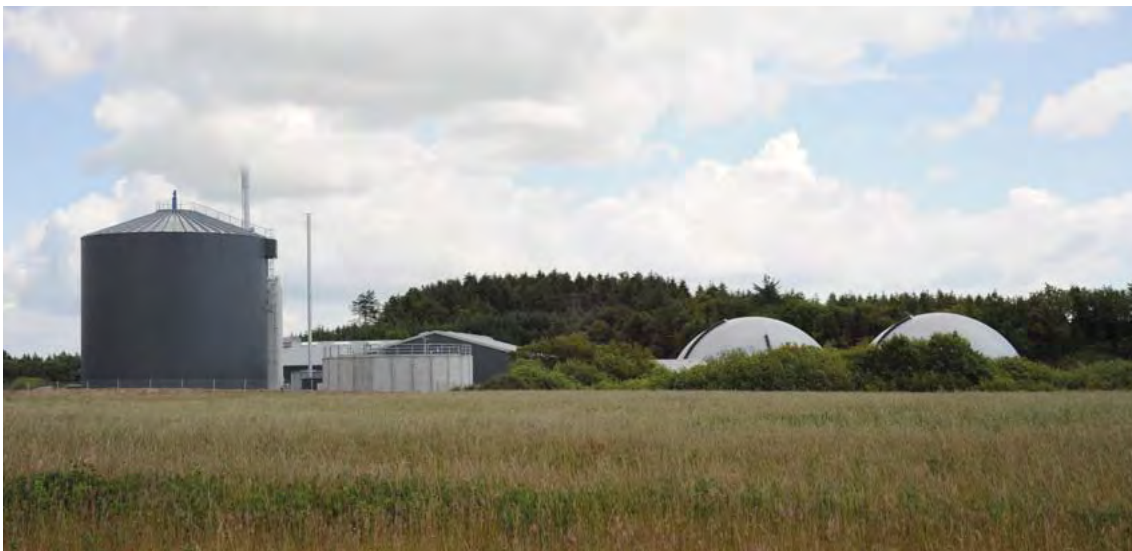
Et nyt biogasanlæg er for nylig blevet færdigbygget og er nu taget i brug. Anlægget ligger godt gemt inde mellem beplantninger og er ikke særlig iøjenfaldende fra de omgivende områder.
