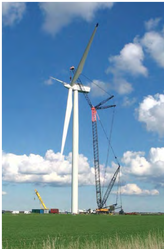
Arbejdsplads med kraner under opførelse af vindmølle, her 3,6 MW mølle med en totalhøjde på 143 m. Foto: Siemens Windpower
